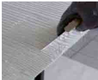
Die Randbereiche mit der Zahnpachtel abziehen.
